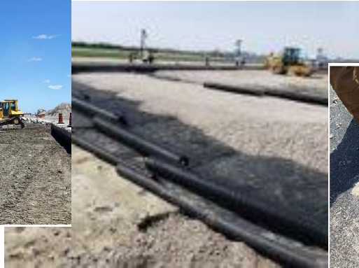
Construire la subsurface et la mise en place granulaire (à l'aide de béton recyclé)
