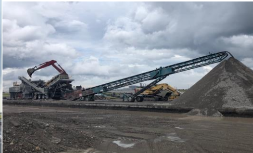
Concasser le béton
