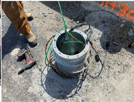
Installer des boîtiers de base pour les lumières
