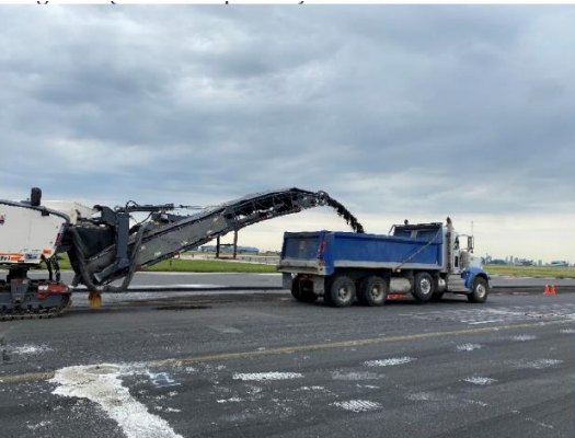
Broyer la surface pour enlever l'asphalte.
