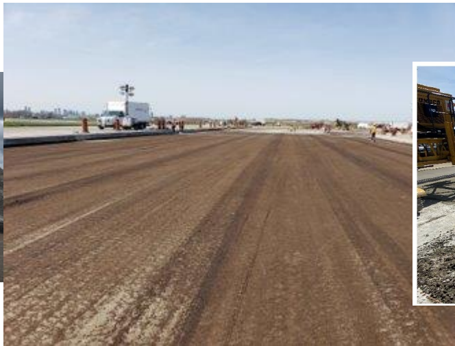
Installation de la base stabilisée au ciment
