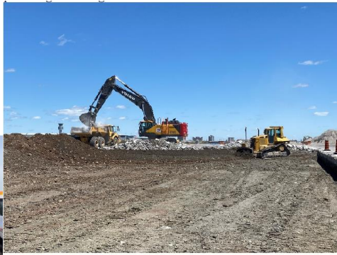
Briser et retirer le béton
